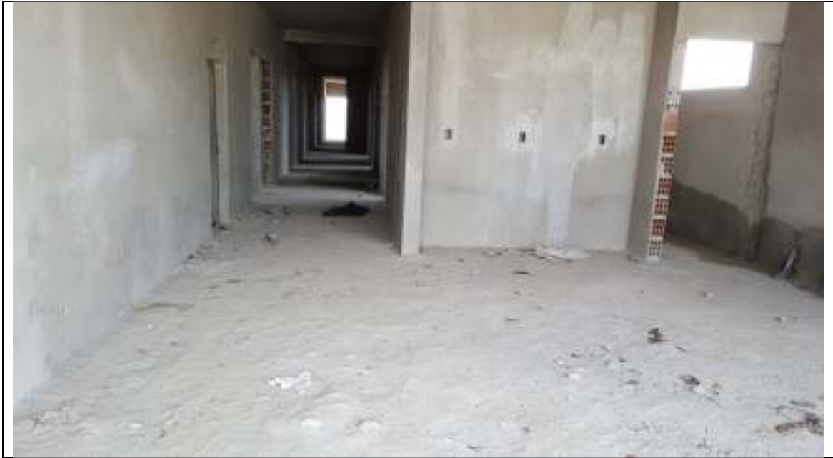
Foto: Vista do interior da Construção da Unidade Básica de Saúde – Equipe B.
