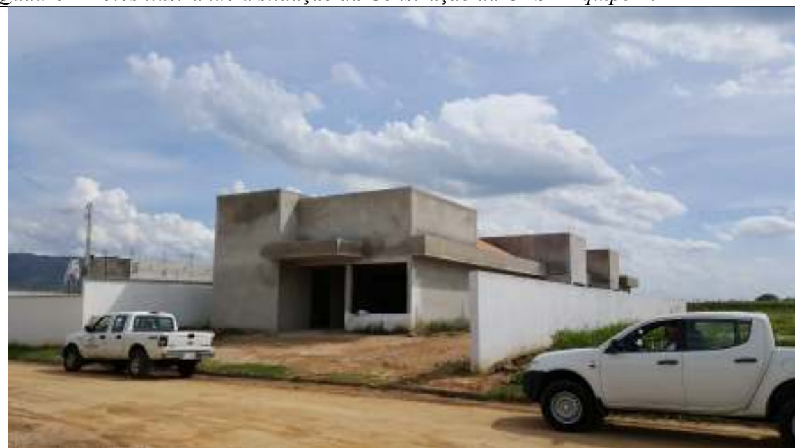
Foto: Vista frontal da Construção da Unidade Básica de Saúde – Equipe B.
