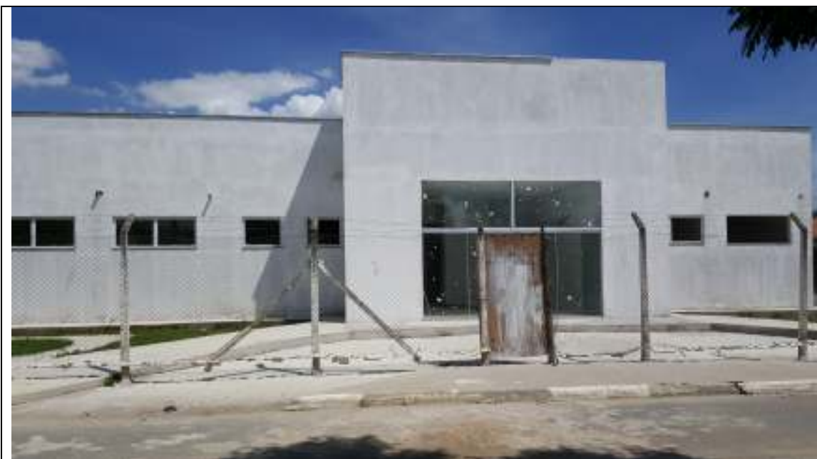
Foto: Vista frontal da Construção da Unidade Básica de Saúde – Equipe A.
