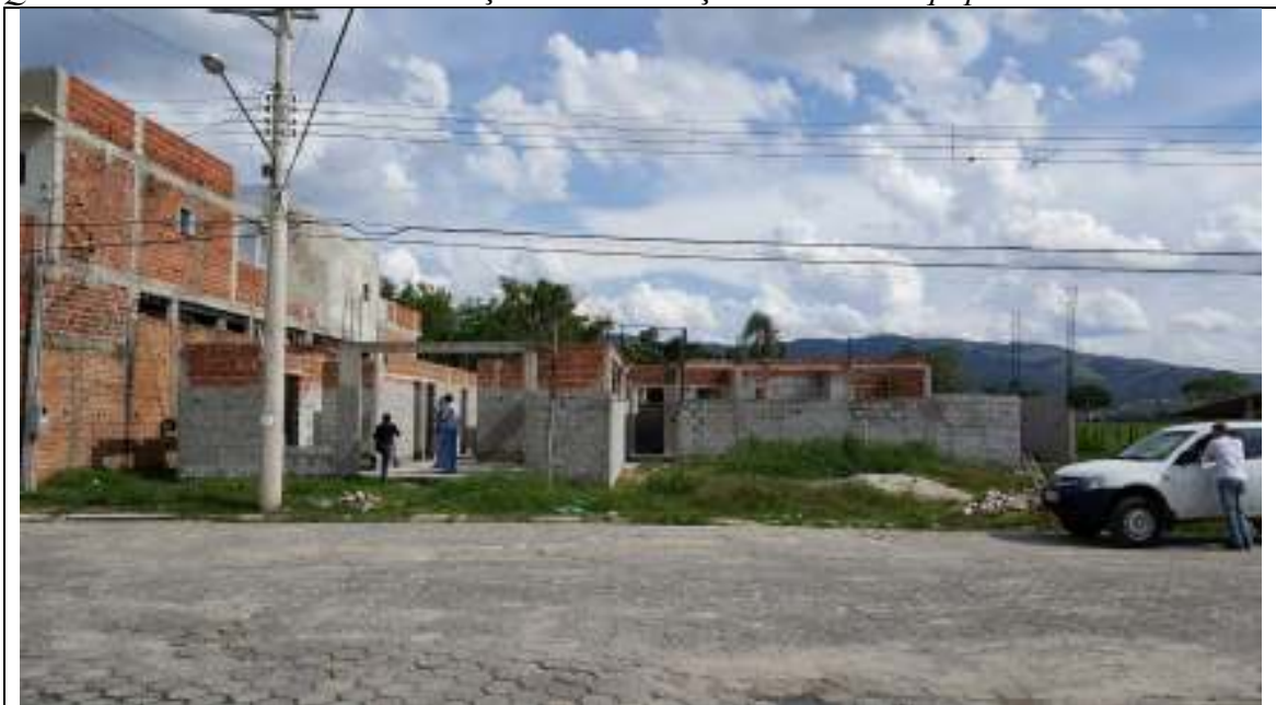
Foto: Vista frontal da Construção da Unidade Básica de Saúde – Equipe D.
